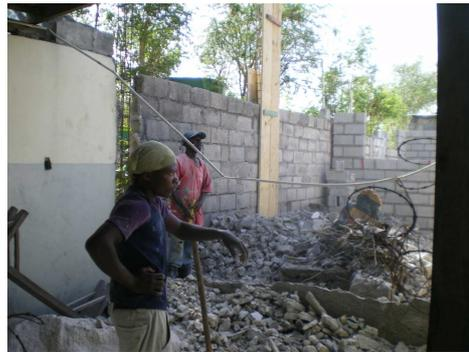
Avec une équipe de 6 maçons, les travaux ont duré 2 mois. Il a fallu de gros travaux pour démolir et déblayer les ruines suite au séisme, pour préparer le terrain. Il n'a pas été possible comme prévu de garder des murs, trop fragiles. Derrière l'espace on aperçoit les arbres des jardins urbains.
