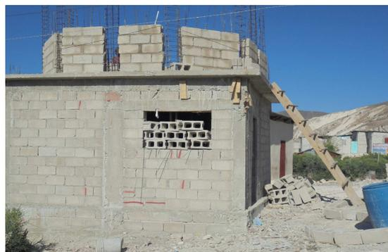
12 piliers en béton armé encercleront le réservoir de 60000 litres. Deux couronnes de béton le renforceront. L'eau sera vendue au seau.
