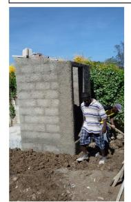
Pour les toilettes, qui augmentent beaucoup le budget, il faut une fosse de 3m/2m sur 4 mètres de profondeur. Le problème est que l'on trouve de l'eau très polluée, à cause des ordures déposées depuis des décennies ... à 3 mètres, ce qui complique la construction. La fosse est en béton armé.
